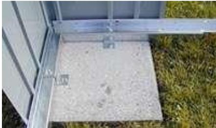
Das Gerätehaus wird beim Aufbau auf den optionalen Bodenrahmen gestellt und mit dem mitgelieferten Befestigungsmaterial an allen Fundamentpunkten je 2-mal befestigt. Größere Häuser müssen auch zwischen den Eckpunkten befestigt werden!
